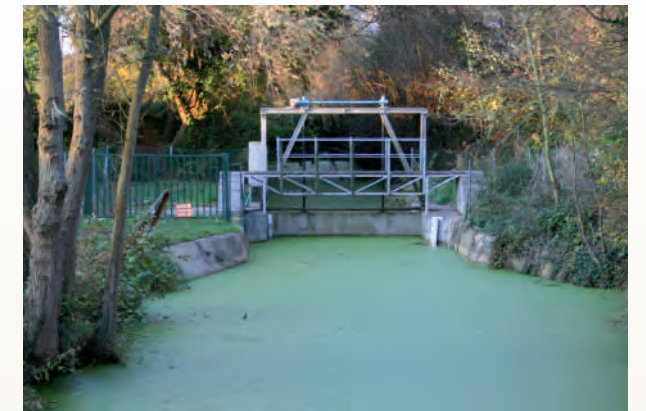
Le vannage installé sur le canal St-Aubin permet de réguler le niveau d'eau du marais Vernier tourbeux. - PNRBSN / F.Rosanska
