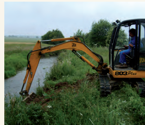
Restauration du profil de la berge avant l'implantation d'une ripisylve, Eaulne (76) - CenNS
