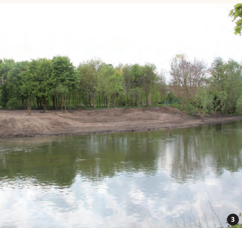
Restauration de berges et d'une zone humide en continuité avec l'Eure sur l'île du Roi à Val-de-Reuil (27). Décaissement en paliers d'une banquette en surplomb de l'Eure, anciennement colonisée par une végétation rudérale et nitrophile sans connexion avec le cours d'eau, afin de favoriser l'inondation de la zone la plus proche lors des petites crues puis une submersion progressive de l'ensemble des paliers lors des crues plus importantes - Travaux réalisés par la Communauté d'Agglomération Seine-Eure. 1. État initial, 2. Pendant travaux, 3. Après travaux, 4. Recolonisation de la végétation et inondation des berges - L. Morin
