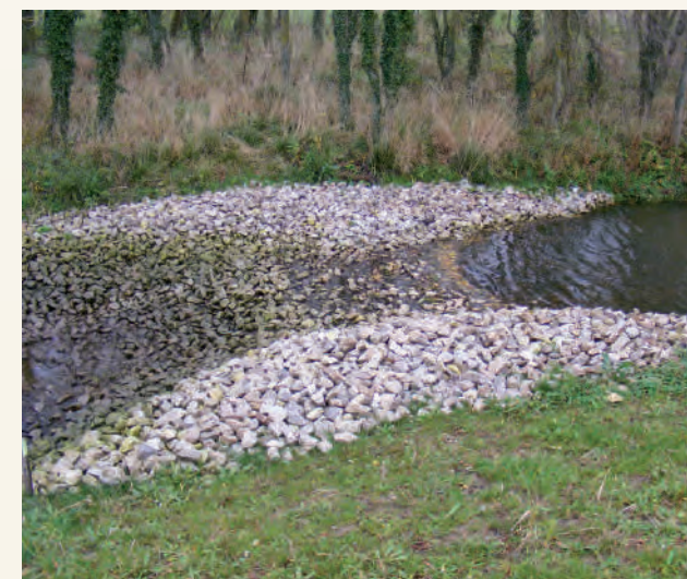
Diversification des substrats et des niveaux du lit mineur du cours d'eau, lors de la reconstitution d'un ancien bras de la Bresle, le Tréport (76) - CenNS / C. Archeray
