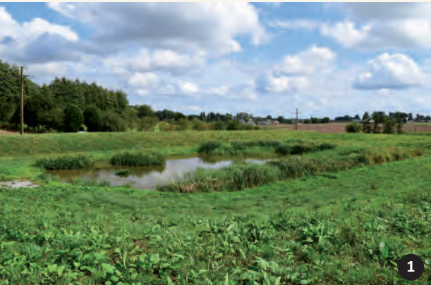
Exemples d'aménagements permettant de réduire les phénomènes d'érosion, de ruissellements, mais aussi les transferts de polluants : 1. Bassin de prévention des inondations dans le pays de Caux - 2. Bassin d'épuration dans le pays de Caux - A. Dardillac
